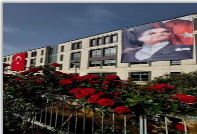
Kampüsümüzde Yapılan Peyzaj Çalışmaları
